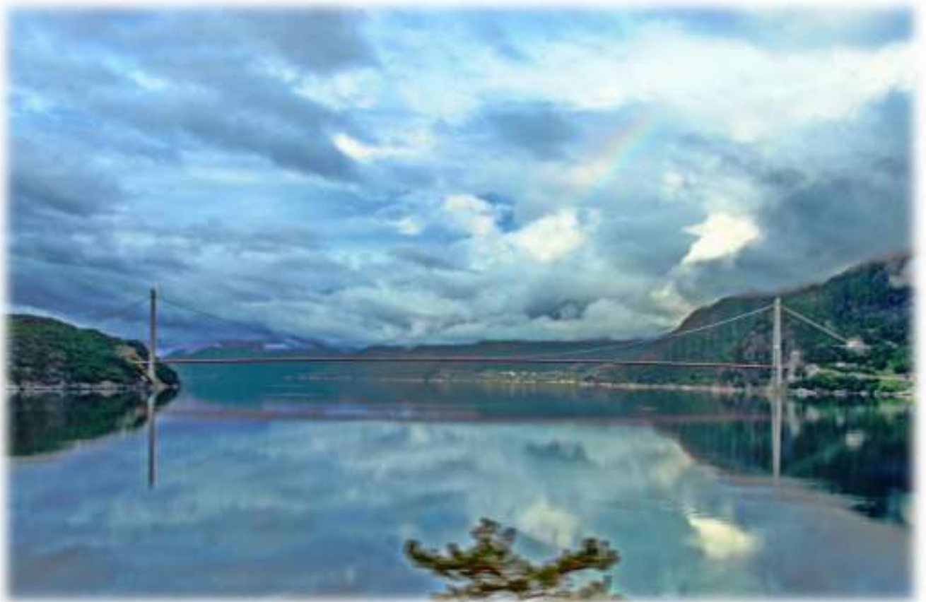
Die Brücke zum Butunnelen naht
