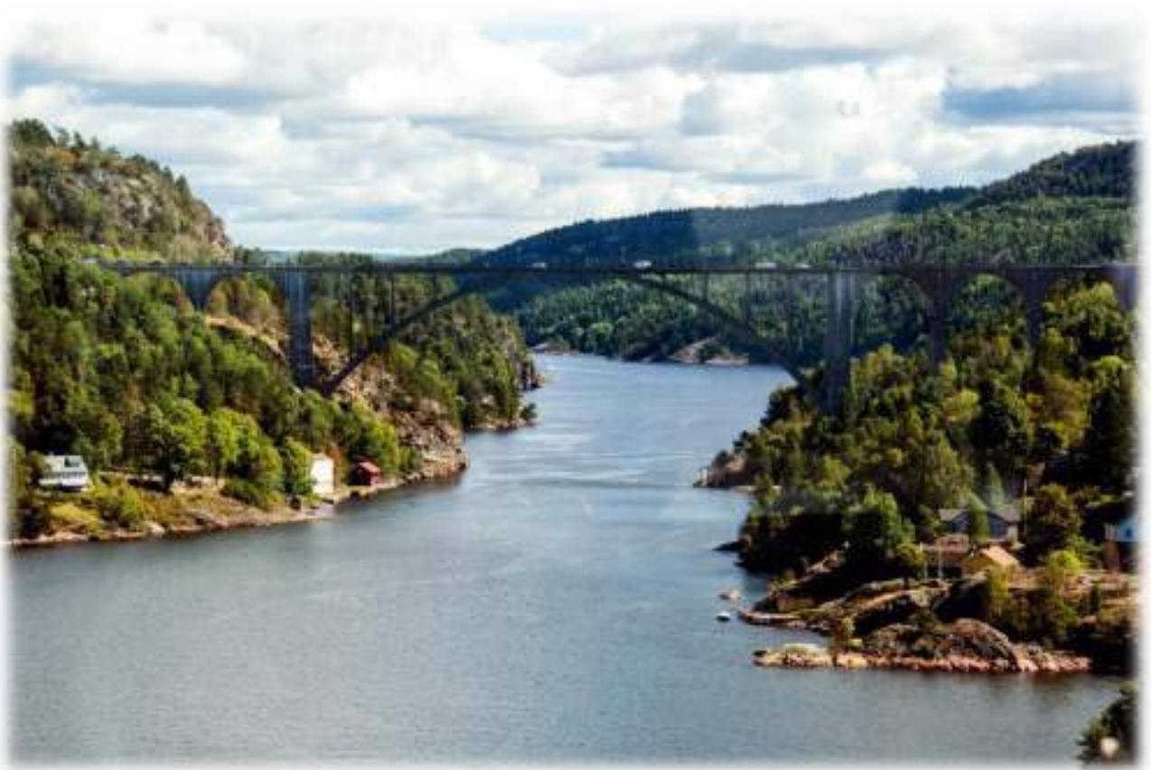
Parallel verlaufende Straßen-Brücke über den Svinesund
