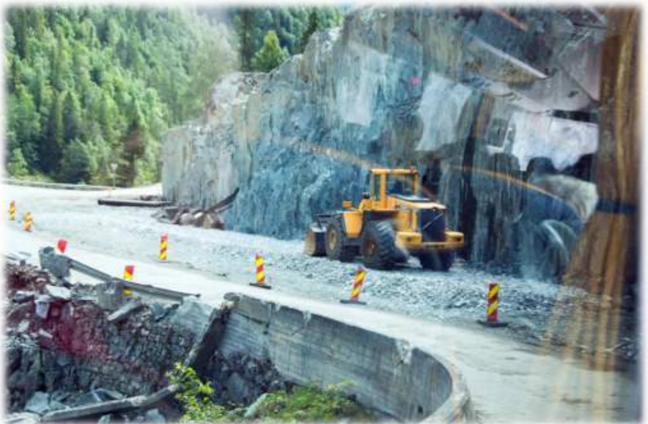
Die nächste Baustelle
