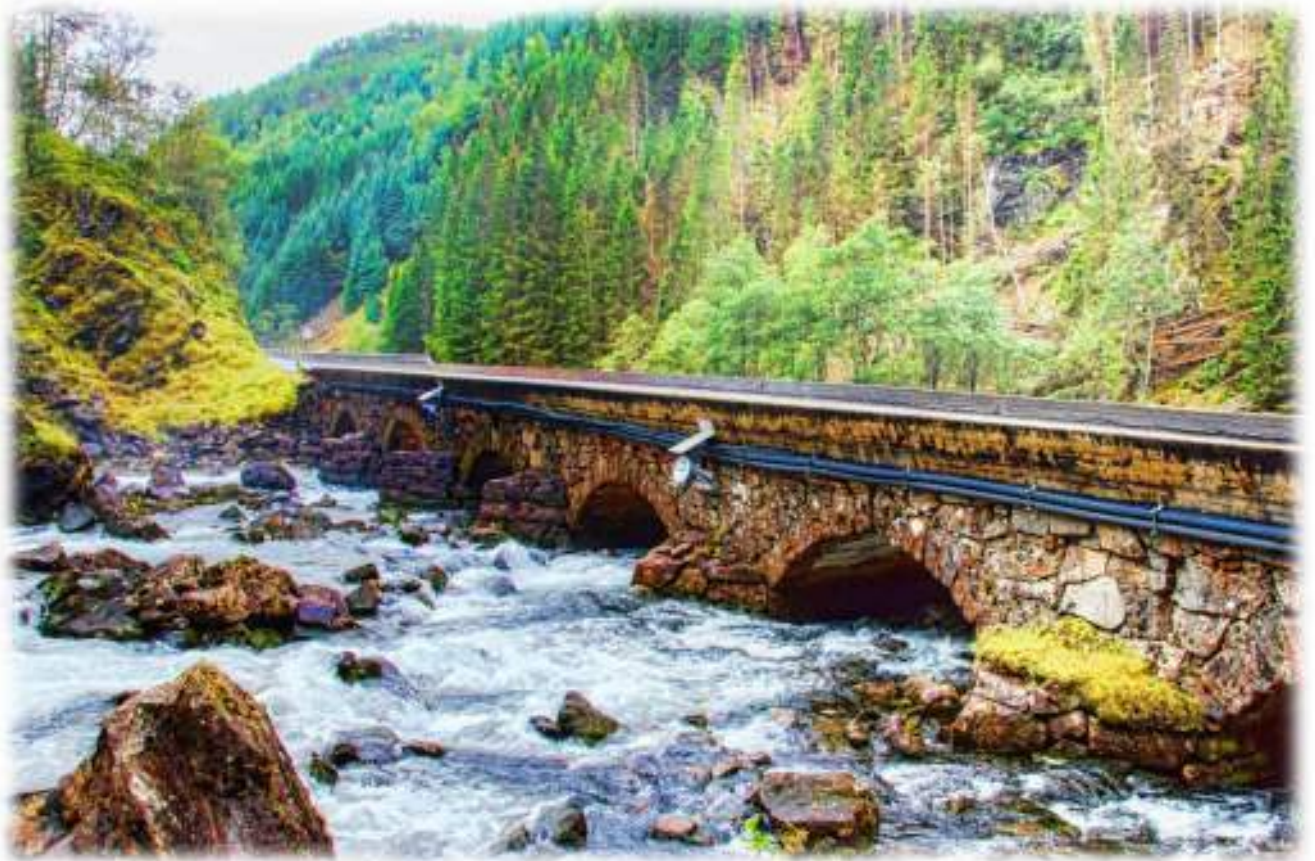
Gemeinsam unter der Brücke durch
