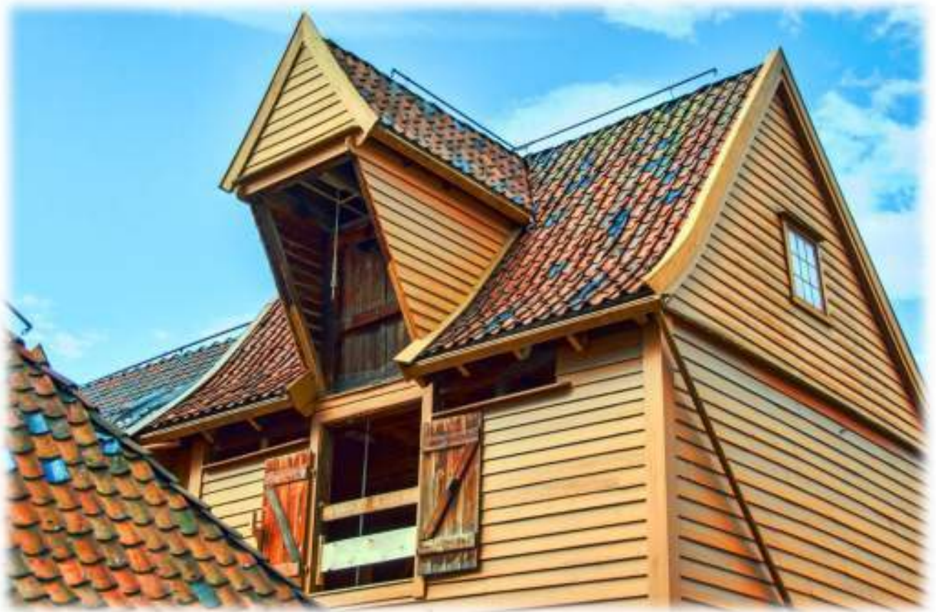
Dieser Aufzug ist noch in Betrieb
