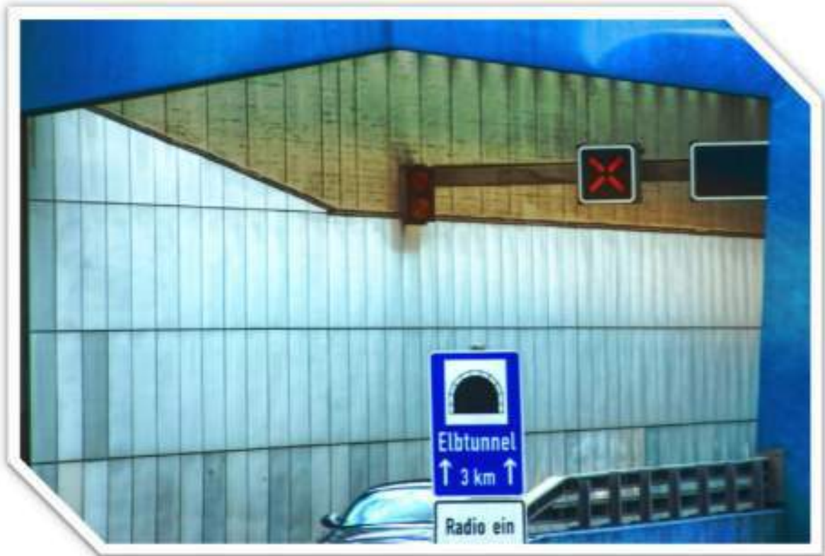
Einfahrt in den Elbtunnel in Hamburg
